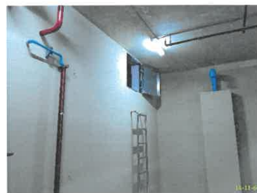
ปั๊ม และถังเก็บน้ำสำรองเพื่อการดับเพลิงชั้น 28M อาคาร A
