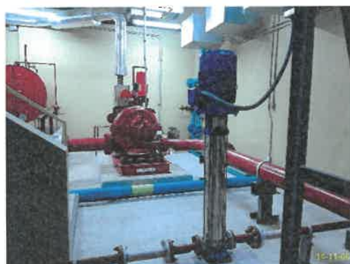
ปั๊ม และถังเก็บน้ำสำรองเพื่อการดับเพลิงชั้นใต้ดิน อาคาร A
