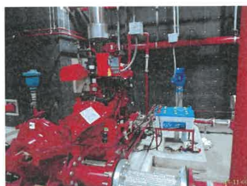
ปั๊ม และถังเก็บน้ำสำรองเพื่อการดับเพลิงชั้น 28M อาคาร A
