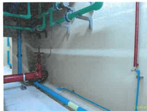
ปั๊ม และถังเก็บน้ำสำรองเพื่อการดับเพลิงชั้นใต้ดิน อาคาร A
